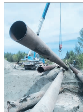
Трудоёмкая переукладка пульповодов хвостового хозяйства возможна только при наличии спецтехники
